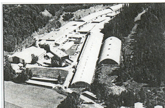
Norsk Eternitfabrikk på Slemmestad, en del av Norcem-konsernet.
