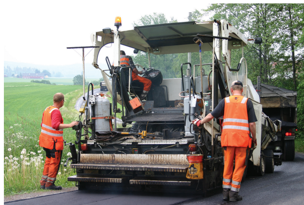
Asfaltering av vei i Enebakk
