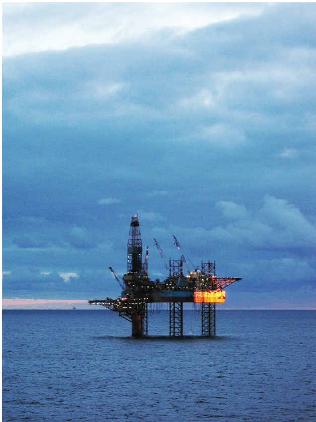
Oljeplattform i Nordsjøen. Foto: Jorunn Kirkeleit (2004)
