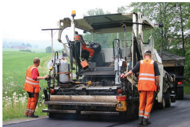
Asfaltering av vei i Enebakk
