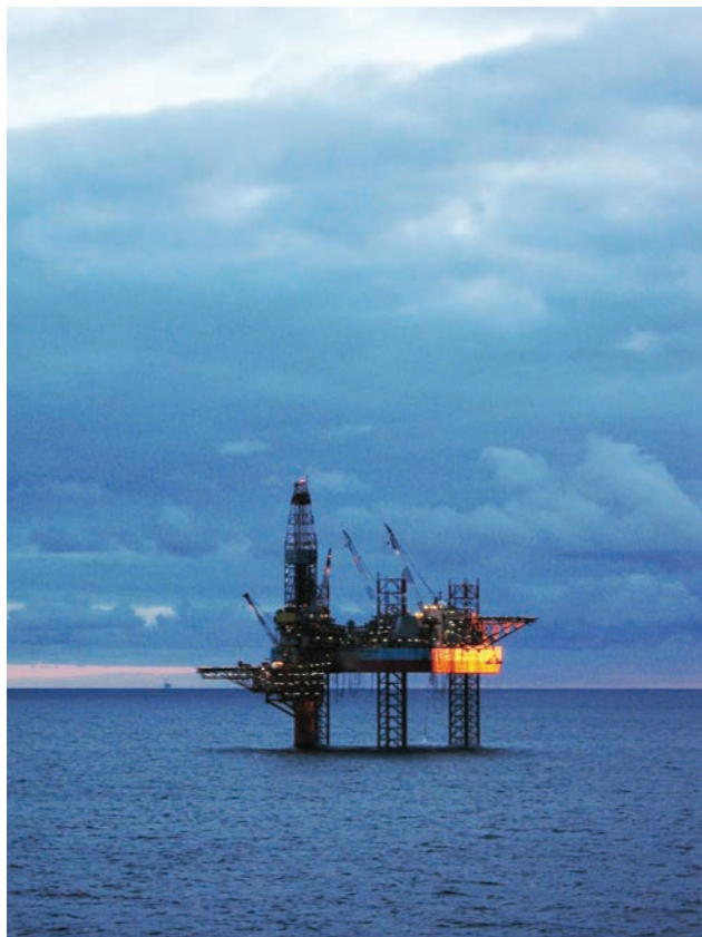
Oljeplattform i Nordsjøen. Foto: Jorunn Kirkeleit (2004)
