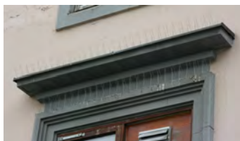
Eksempel på fuglesikringsutstyr i form av metallpigger som skal hindre fugler i å finne hvile- og hekkeplasser på bygninger.
