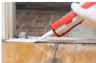
Tett sprekker for å hindre at dyr kommer inn.
